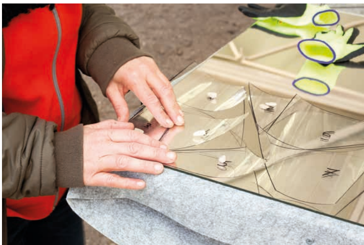
Création des gabarits pour la découpe des miroirs Vue du chantier de restauration, mai 2021 Crédit photo : Camille Verrier
